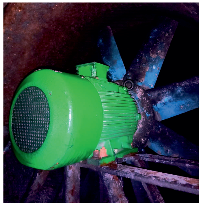
15kW / 4P Motor for Humidifier Fan
